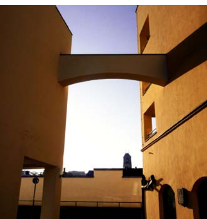
Blick vom Innenhof in Richtung Altstadt Wasserburg
